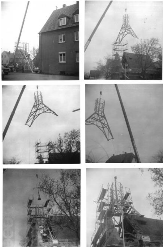
Einbau der Stahlkonstruktion zur Stabilisierung, 1982
